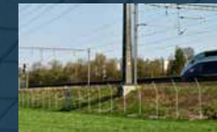
Sicherung von Eisenbahnstrecken
