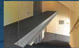
Treppenhaus Mehrfamilienhaus (CH)
